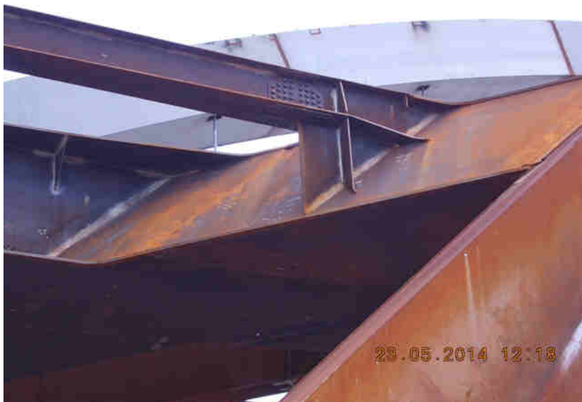
COLLEGAMENTI IMPALCATI «A» E «C» - TRAVERSONE
