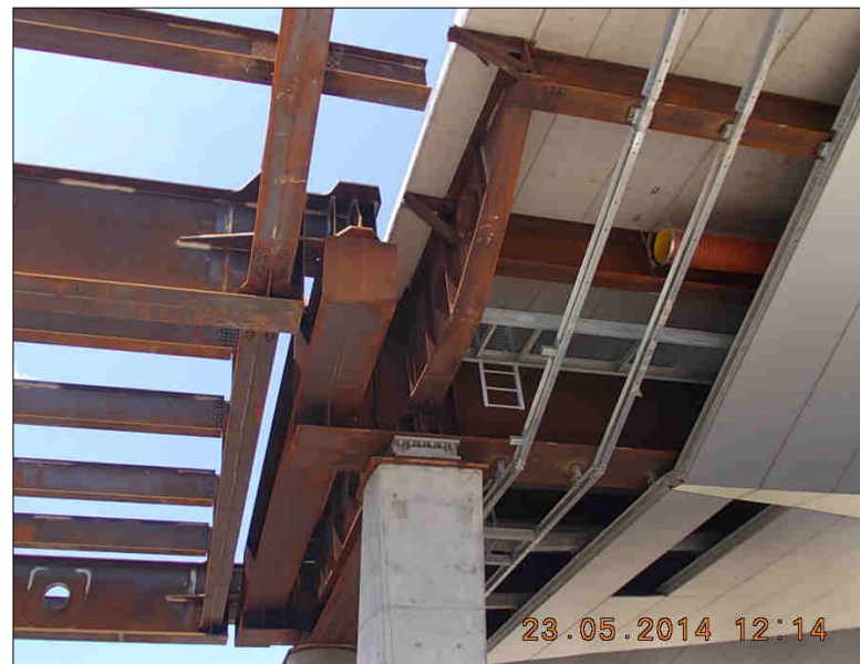
TRASVERSO ESTREMITÀ LATO PONTE A4
