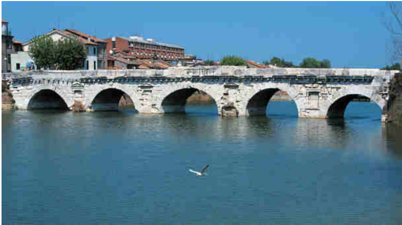
Ponte di Tiberio, Rimini Muratura «antica» (I sec.) : - Elevato grado di occlusione - Archi a tutto sesto
