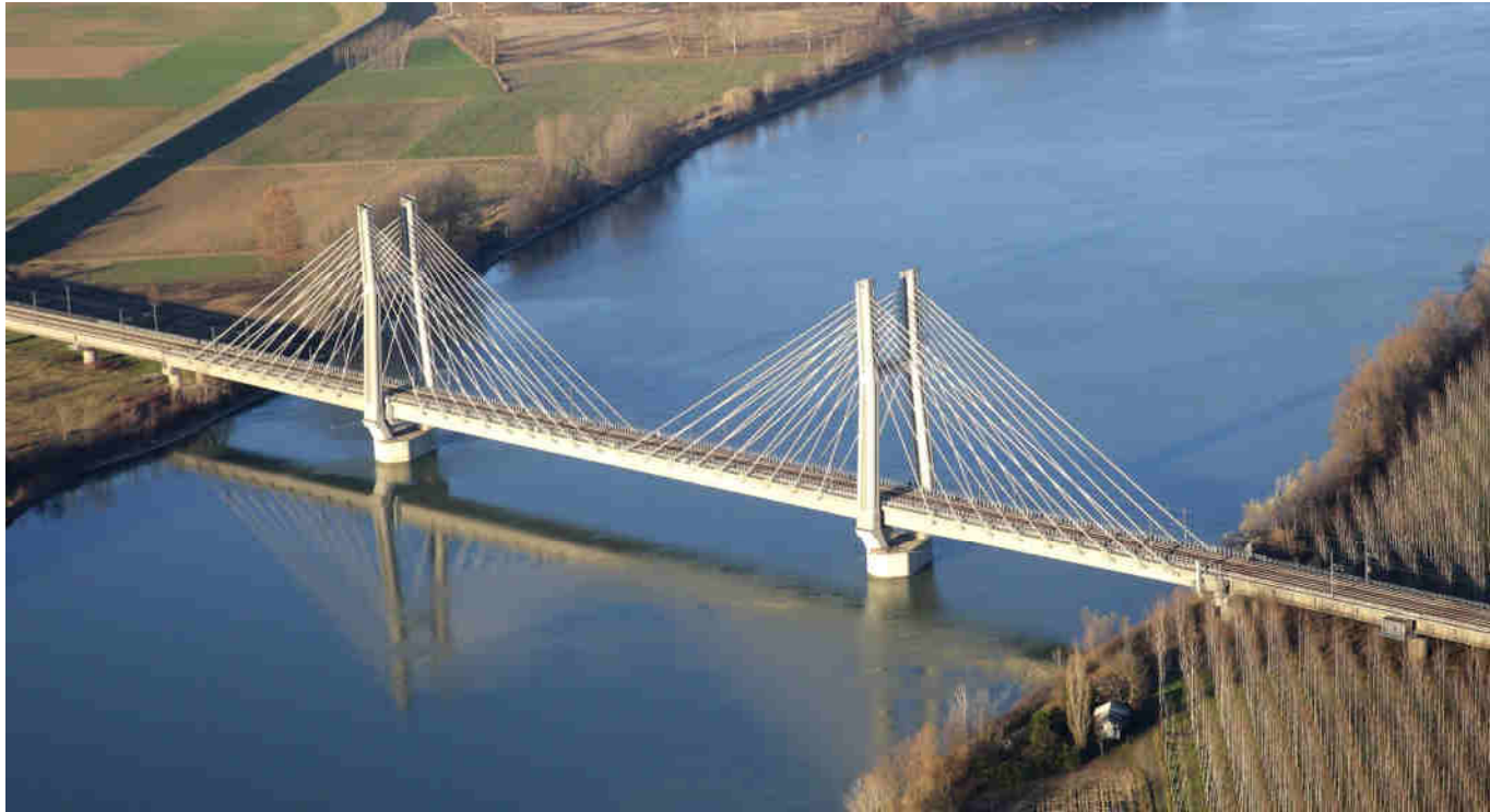
Ponte ferroviario strallato sul fiume Po a Piacenza
