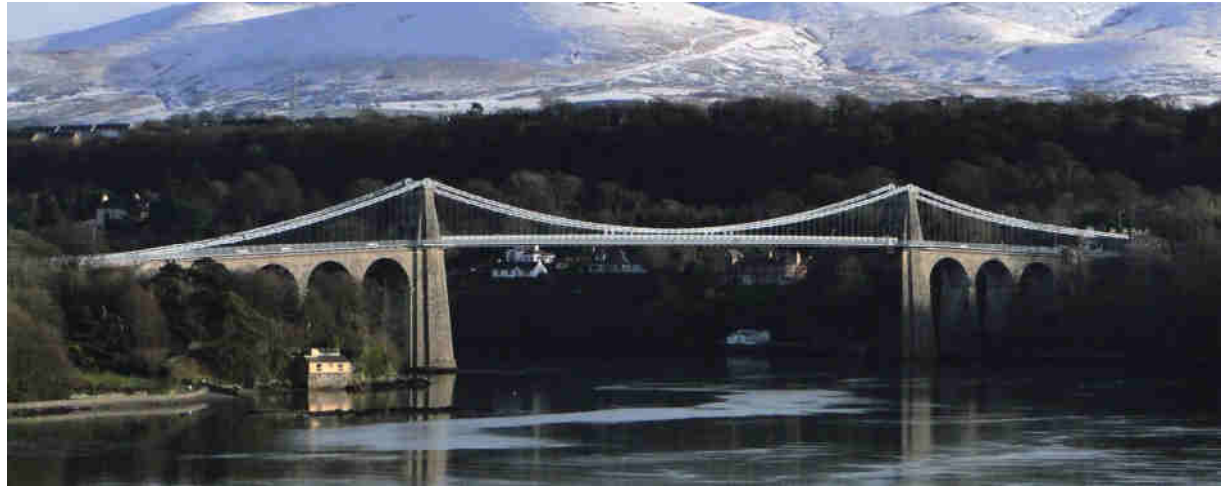
Ponte sospeso sul Menai (1826) Thomas Telford, sempre in servizio
