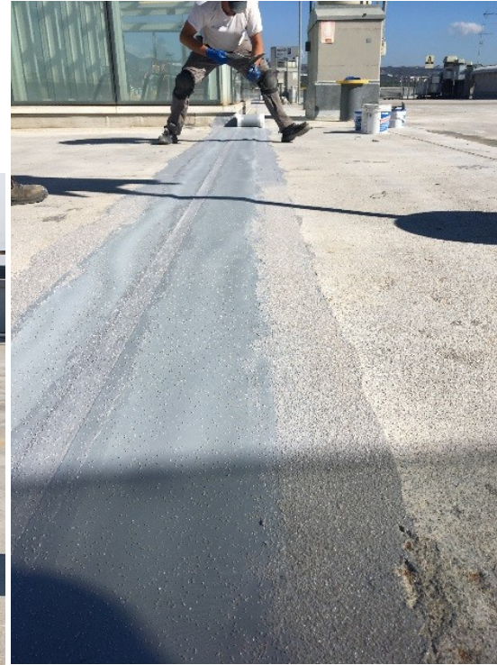
Impermeabilizzazione giunti strutturali
