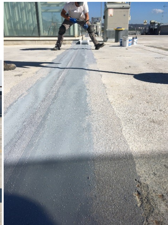
Impermeabilizzazione giunti strutturali
