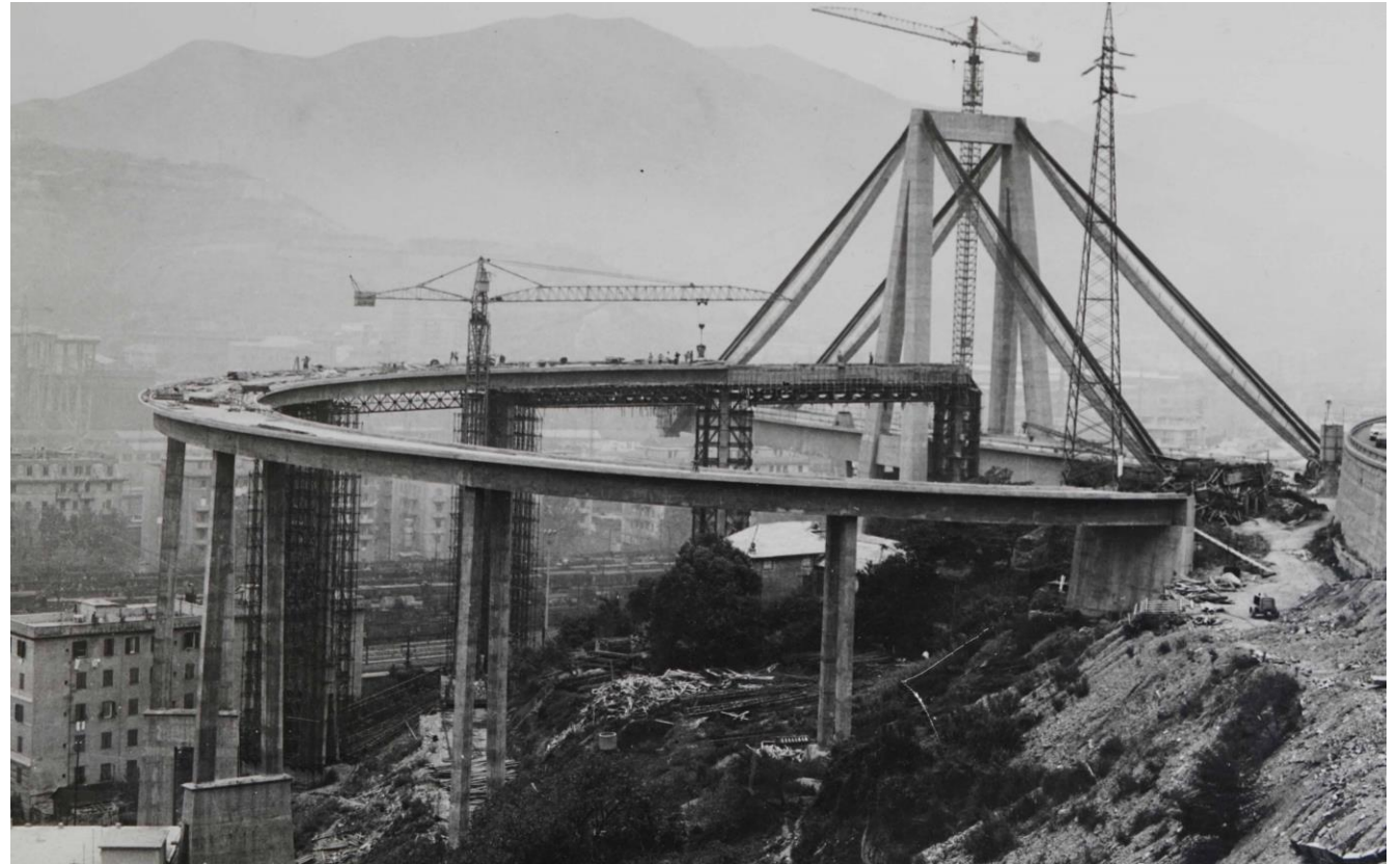
La rampa elicoidale in costruzione
