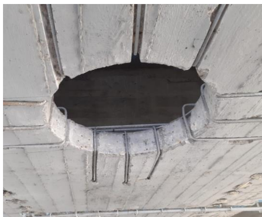
Aperture in controsoletta
