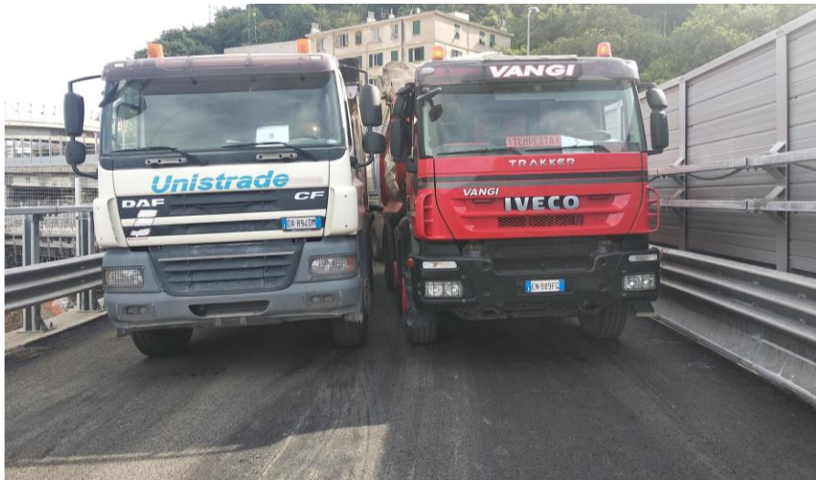
Prove di carico per collaudo statico a fine interventi
