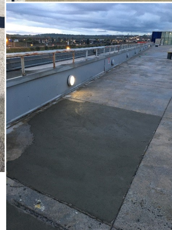
Ripristino pendenze e planarità
