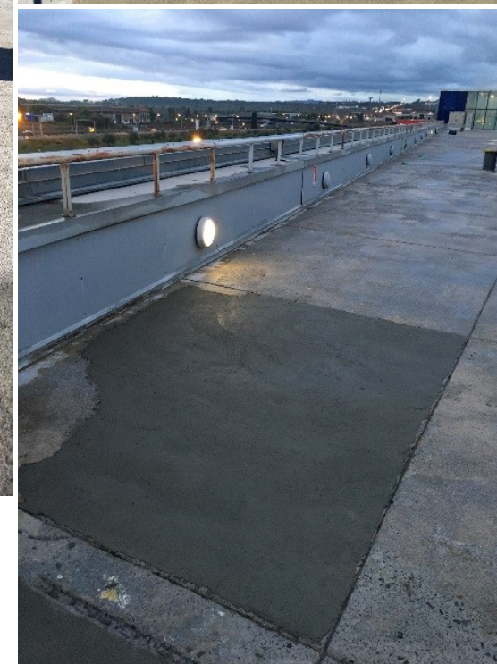
Ripristino pendenze e planarità
