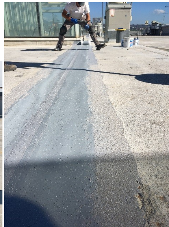
Impermeabilizzazione giunti strutturali
