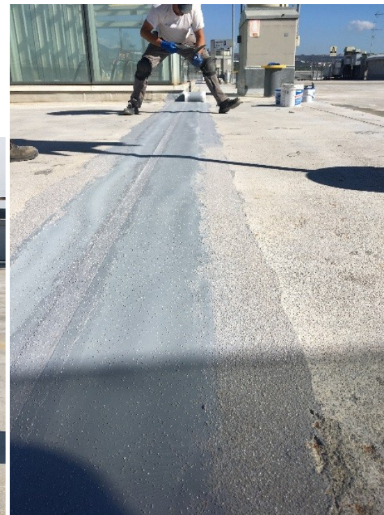
Impermeabilizzazione giunti strutturali
