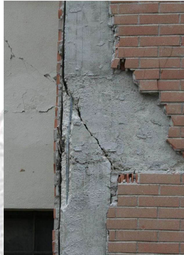
Instabilità armatura pilastro passante nel n
