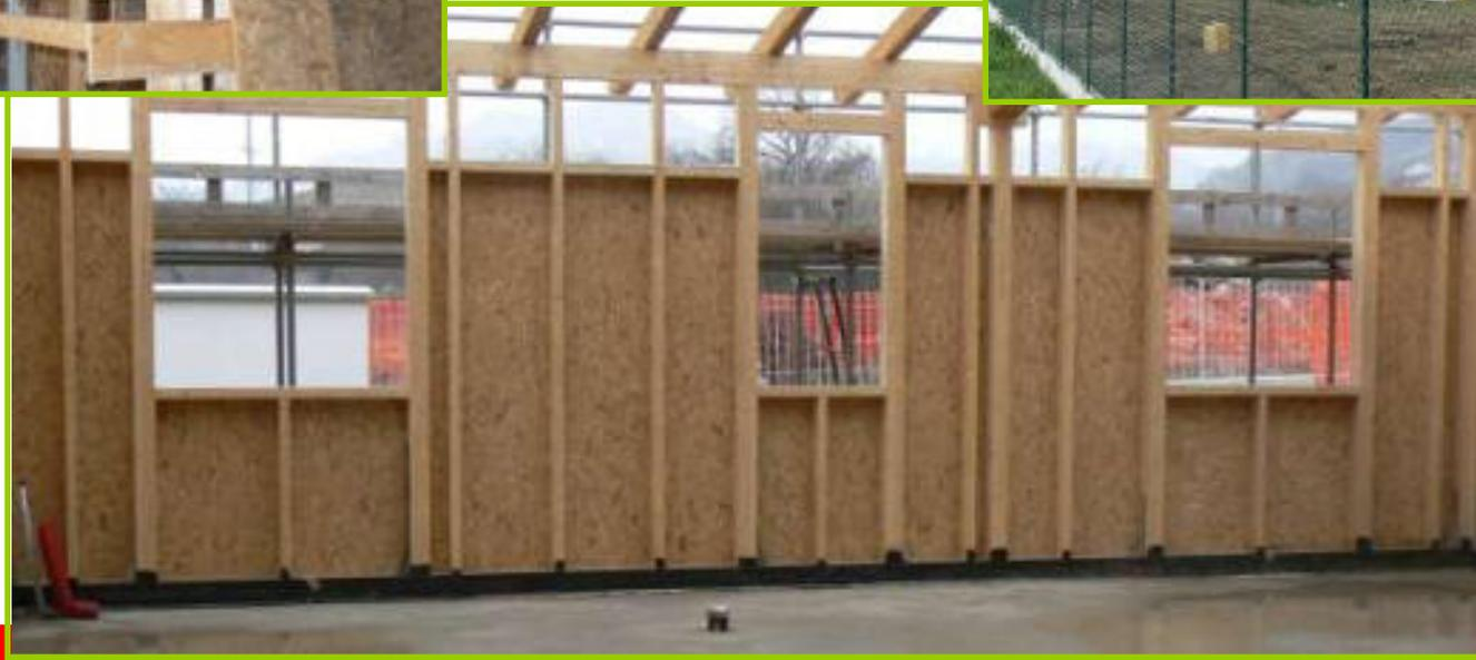
Tipologie: sistema Platform-Frame (telaio)
