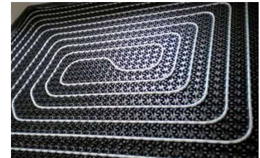
Sistema radiante idronico alimentato da pompa di calore aria-acqua
